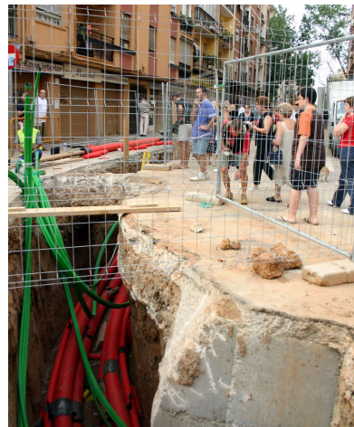
Zanja por la que discurre la línea de alta tensión en el cruce de las calles Santander y General Barroso.
